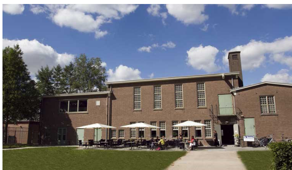
Figuur 2.10 Het Stroomhuis, voormalige regelstation met publieke functie, ontsloten vanaf de Van Pallandweg, gelegen ten zuiden van locatie voor het nieuwe station
