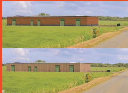
Impressies van voorbeelden van een regelstation, afgewerkt met rode baksteen (boven) en verticale houten geveldelen (onder).
