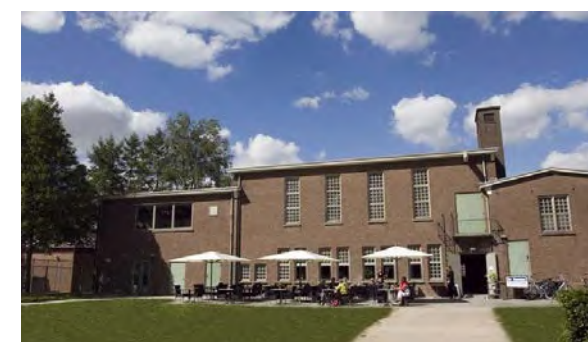
Figuur 2.10 Het Stroomhuis, voormalige regelstation met publieke functie, ontsloten vanaf de Van Pallandtweg, gelegen ten zuiden van locatie voor het nieuwe station
