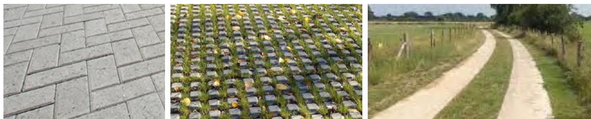
Figuur 4.5 De bestrating van het station bestaat uit klinkers. Qua inrichting zet Liander zich in om zoveel mogelijk groen in te passen, zonder dat dit de functionaliteit van het terrein beïnvloed. Om de hoeveelheid bestrating te minimaliseren en waterinfiltratie te vergroten worden de parkeerplaatsen aangelegd met grasbetontegels en de toegangsweg met een combinatie van halfverharding en gras.
