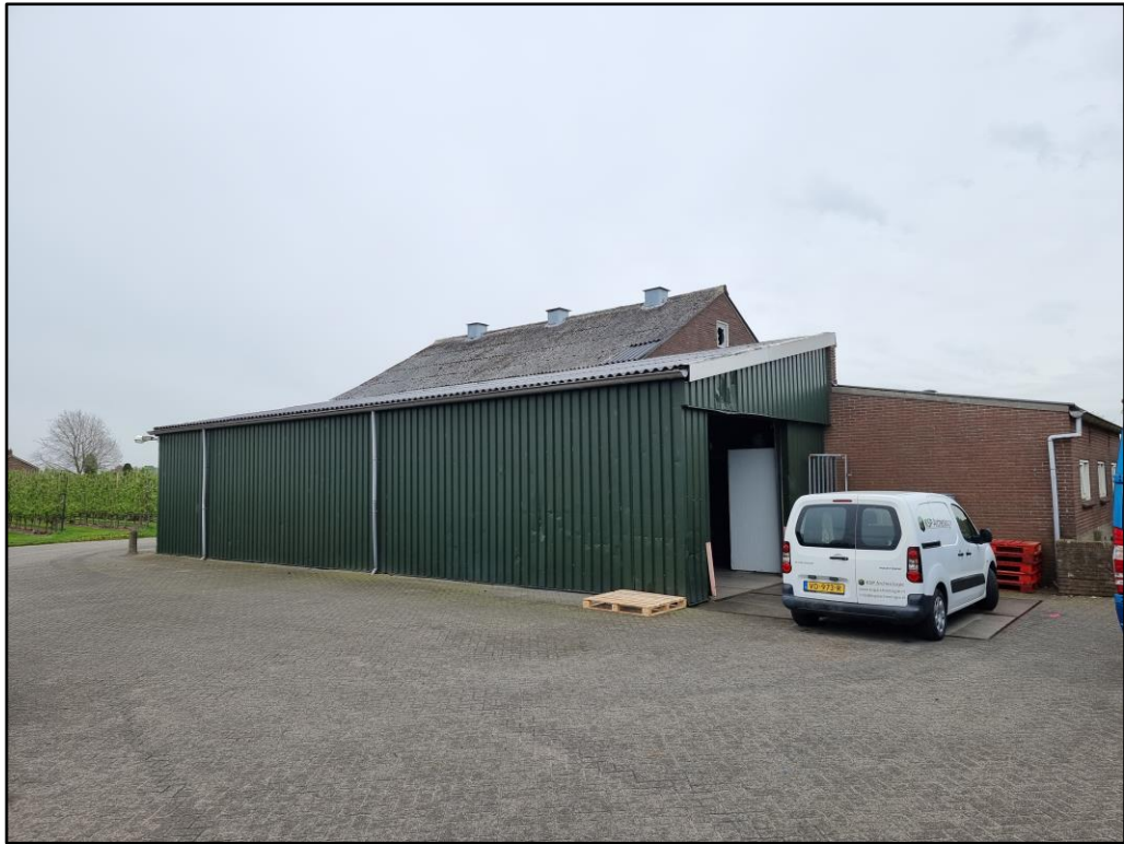
Figuur 3 De te saneren loods op de planlocatie.
