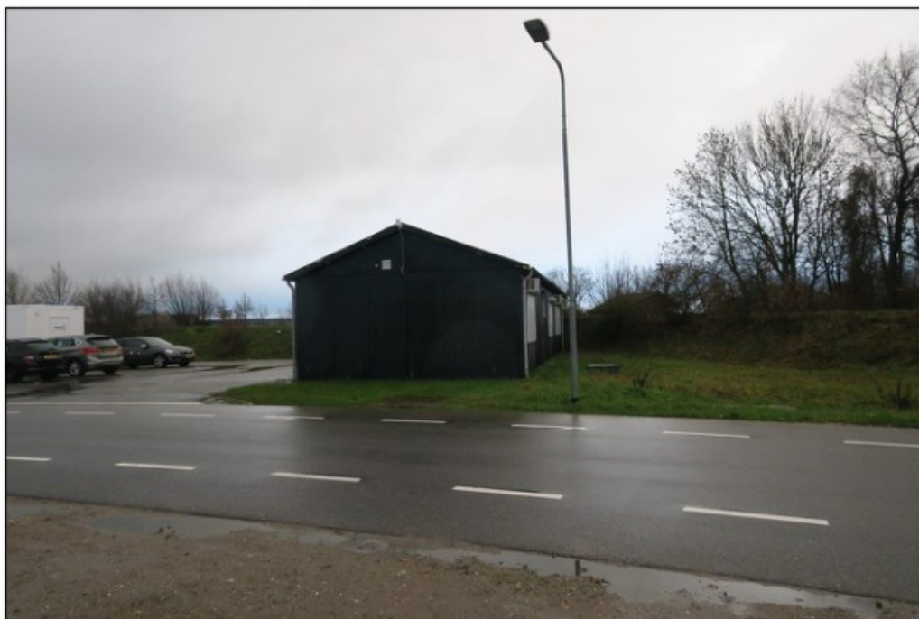
Figuur 2 De loods welke gesaneerd zal worden ten behoeve van de beoogde ontwikkeling.
