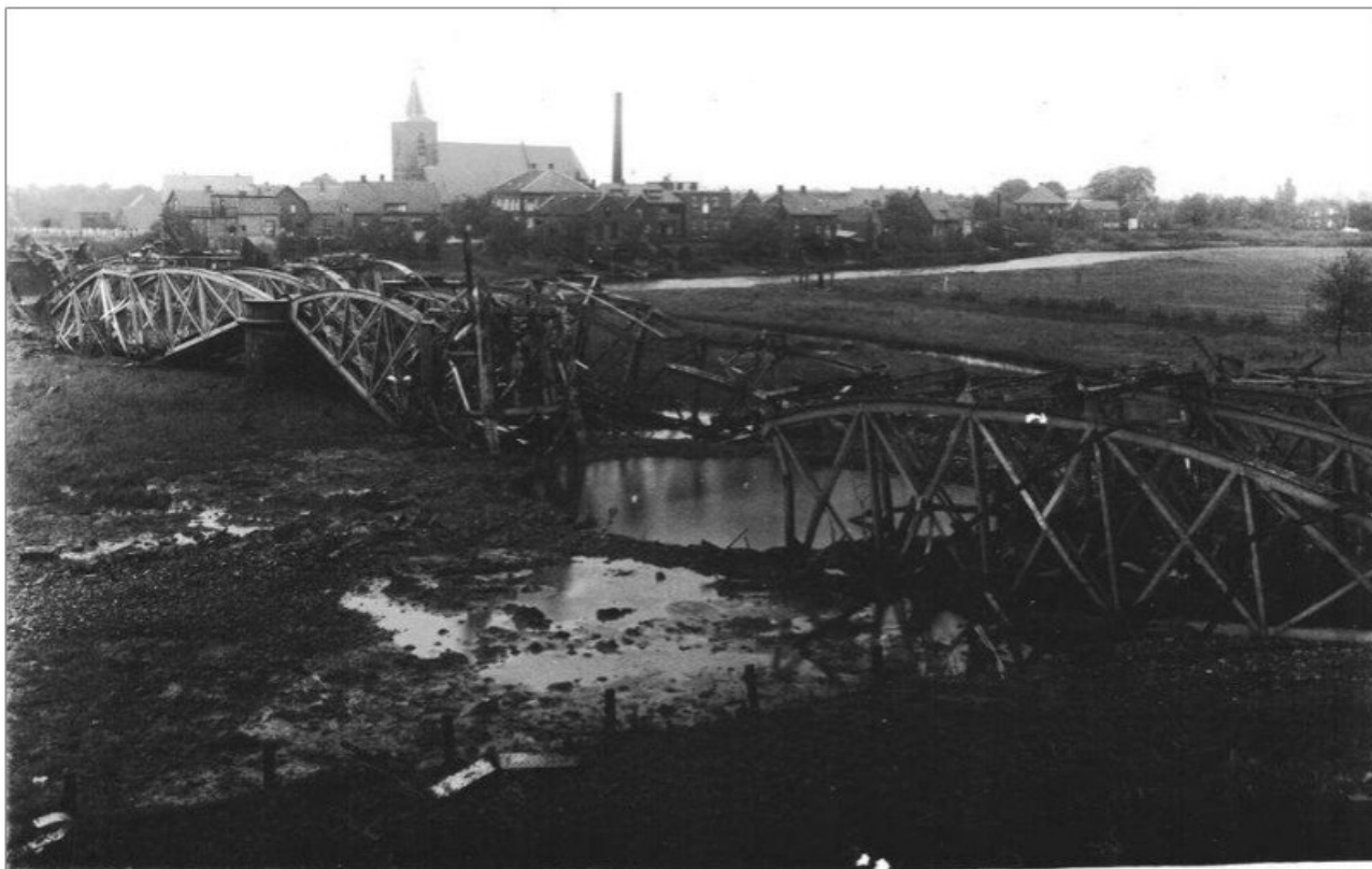
Afbeelding: de door de Duitsers op 17 april 1945 opgeblazen spoorbrug te Geldermalsen.
