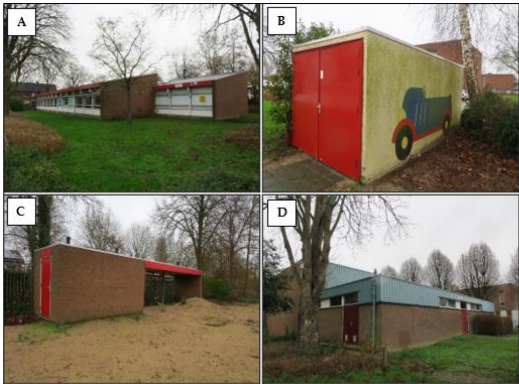
Figuur 1.2 De bebouwing op de planlocatie betreft een voormalige basisschool en gymzaal welke zijn opgetrokken uit gemetselde muren met spouw en een plat bitumen dak (A & D). Schuren opgetrokken uit gemetselde muren en een plat bitumen dak (B & C).
