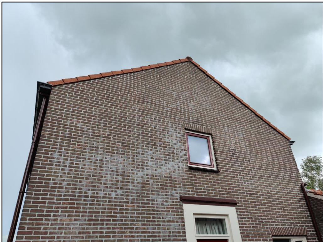
Figuur 4 Onder de kant- en nokpannen van de te saneren woningen kunnen vleermuizen en gierzwaluwen verblijfplaatsen en nestlocaties bereiken.
