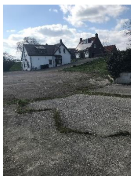
Foto 4: beton en klinkerverharding met woning nr 89 (richting zuiden)
