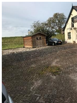
Foto 6: tuinhuis met betonverharding achter woning nr. 89 (richting zuiden)
