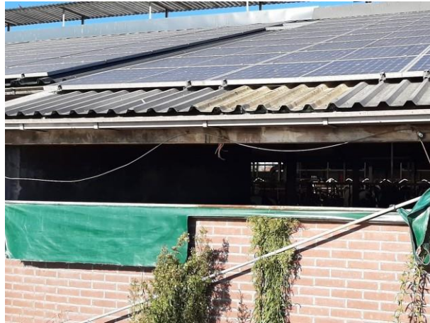
Figuur 16 Detailfoto van het dak van de zuidelijke stal
