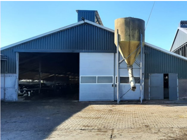
Figuur 15 Oostzijde van de zuidelijke schuur
