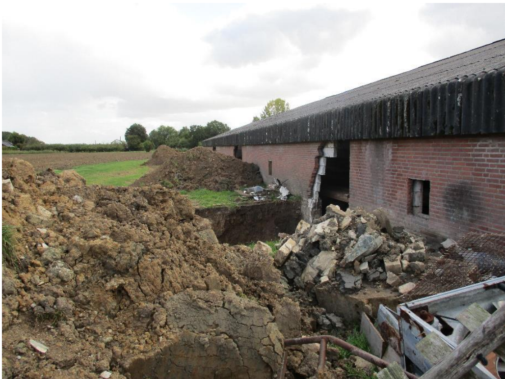
Figuur 6 In de oude melkstal zijn al delen van de muren afgebroken (E).
