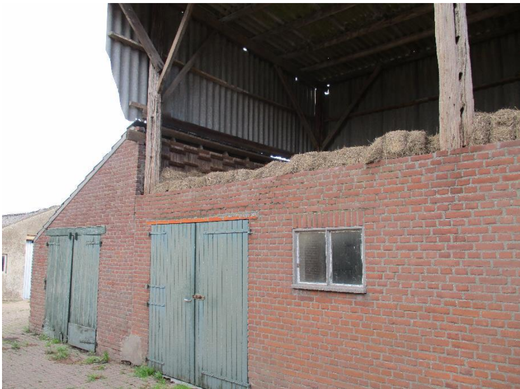
Figuur 4 De deels open hooischuur met op de begane grond oude koeienstallen (C). Deze blijft behouden.
