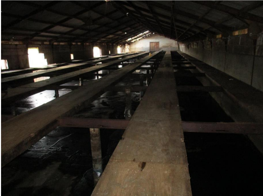
Figuur 6 In de oude melkstal (E) zijn de vloeren en het dakbeschot al verwijderd.
