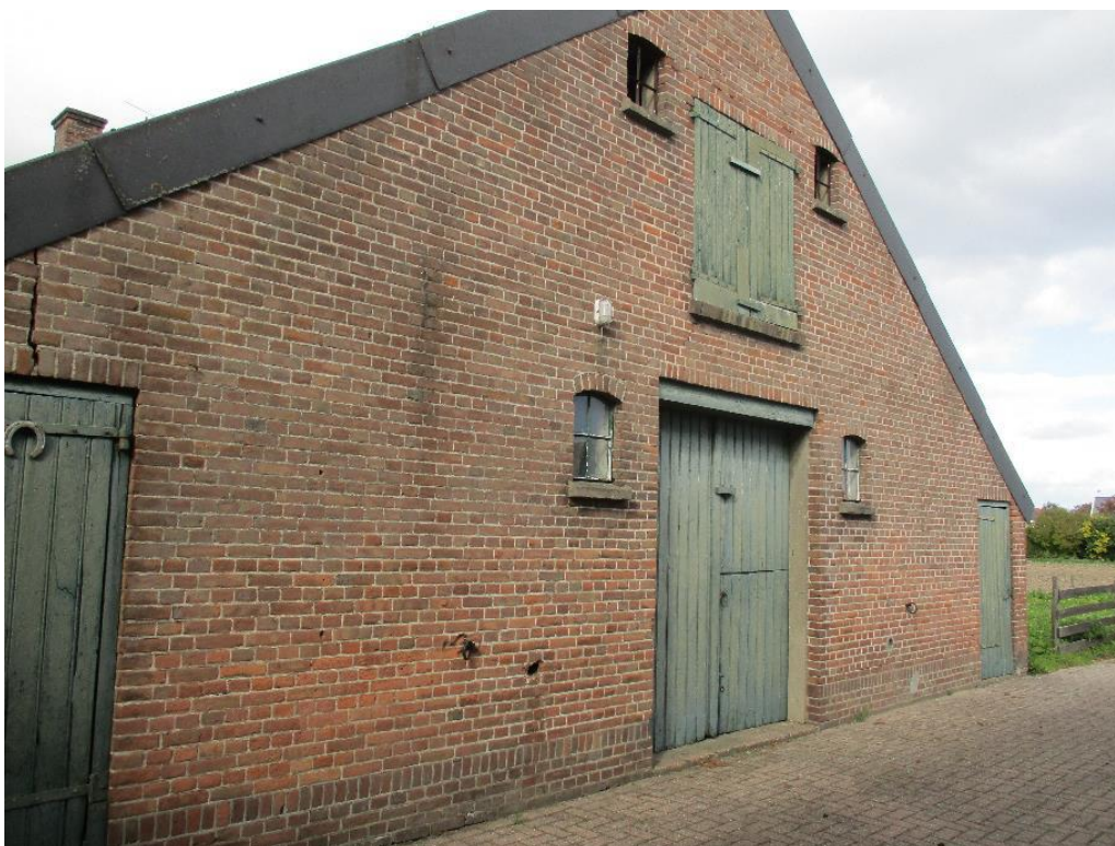
Figuur 2 Aan de achterzijde van de te slopen bedrijfswoning (A) is een aangebouwde schuur aanwezig.
