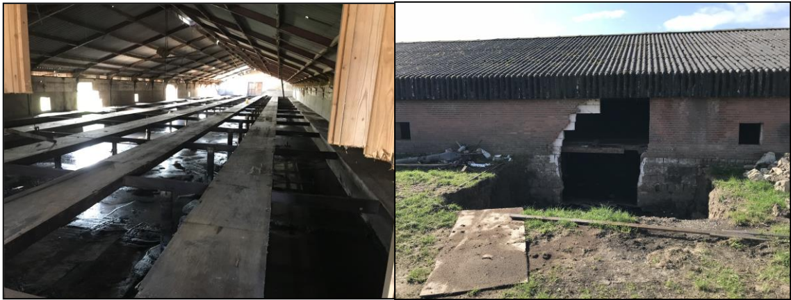
Figuur 11: Foto's van de kelders onder de schuur in het plangebied
