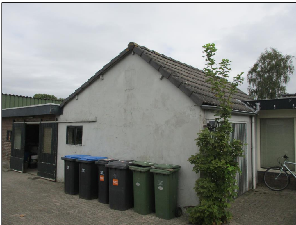
Figuur 3 Een fotografische impressie van een gedeelte van de schuur op het woonperceel.
