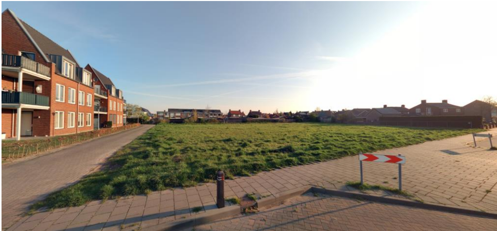
Figuur 8: Aanzicht planlocatie Schoolstraat, gezien vanaf het zuidwesten (april 2023)
