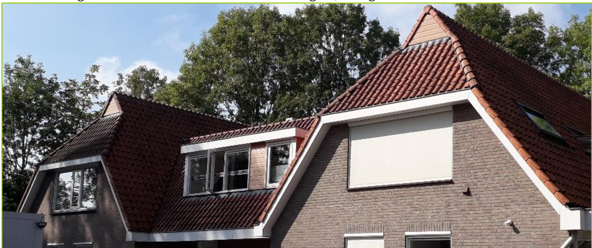
Figuur 2 Overzichtsfoto van het dak van het gebouw
