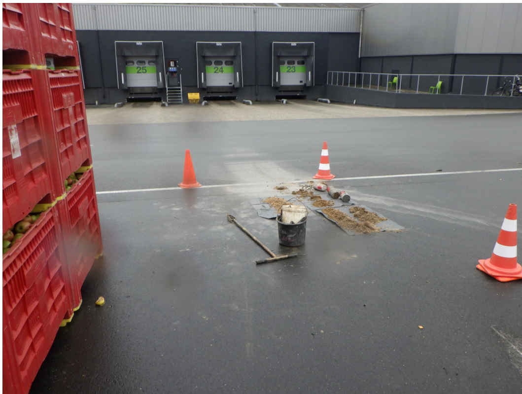
Figuur 4: Foto genomen ter hoogte van boring 7. De laadkuil, te zien achter de boring, loopt af tot ongeveer 150 cm onder het straatoppervlak.
