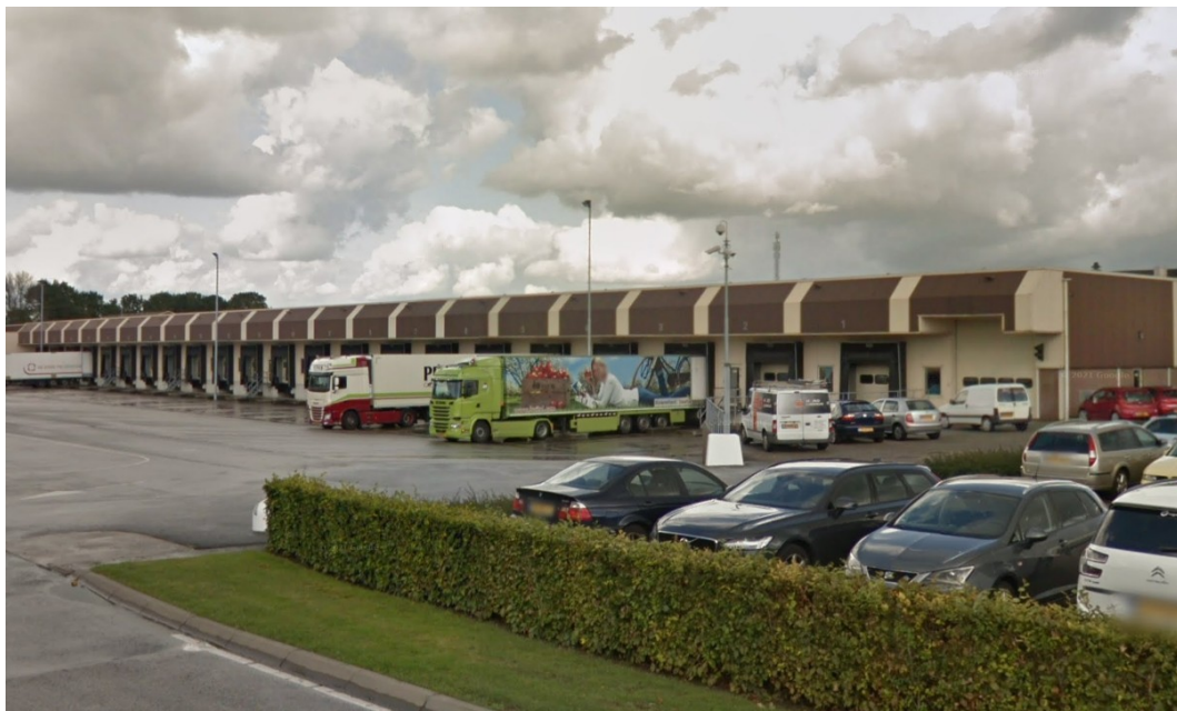
Figuur 11: Laadperrons aan de westzijde van het centrale pakstation (Google Maps Street View, september 2017).
