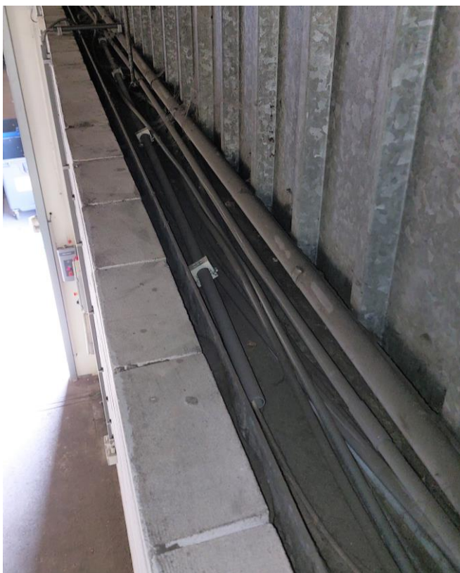
Figuur 4.4.2. De spouwmuur is van boven dicht door de aanwezigheid van een metalen plaat.
