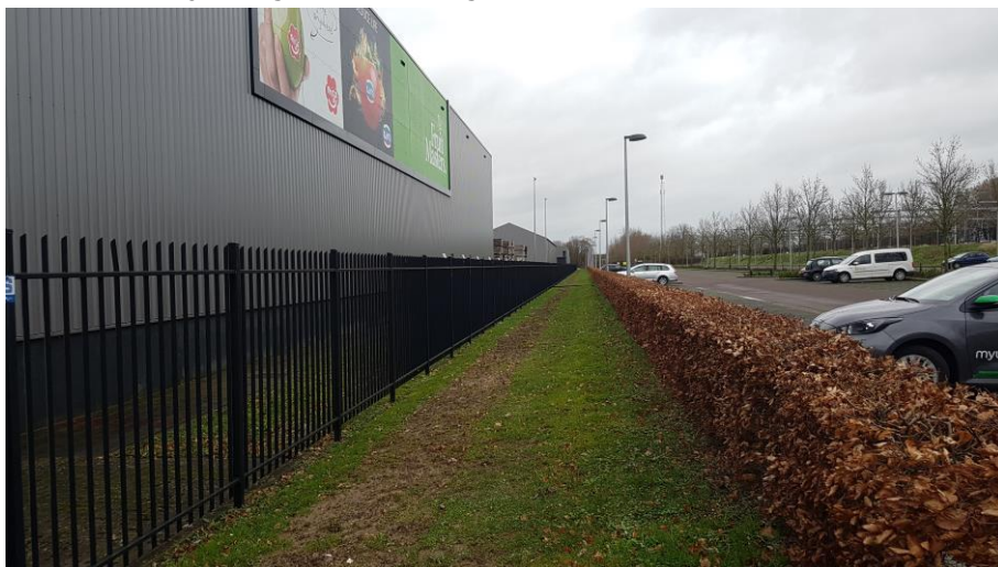
Huidige bedrijfsgebouwen langs spoorzone
