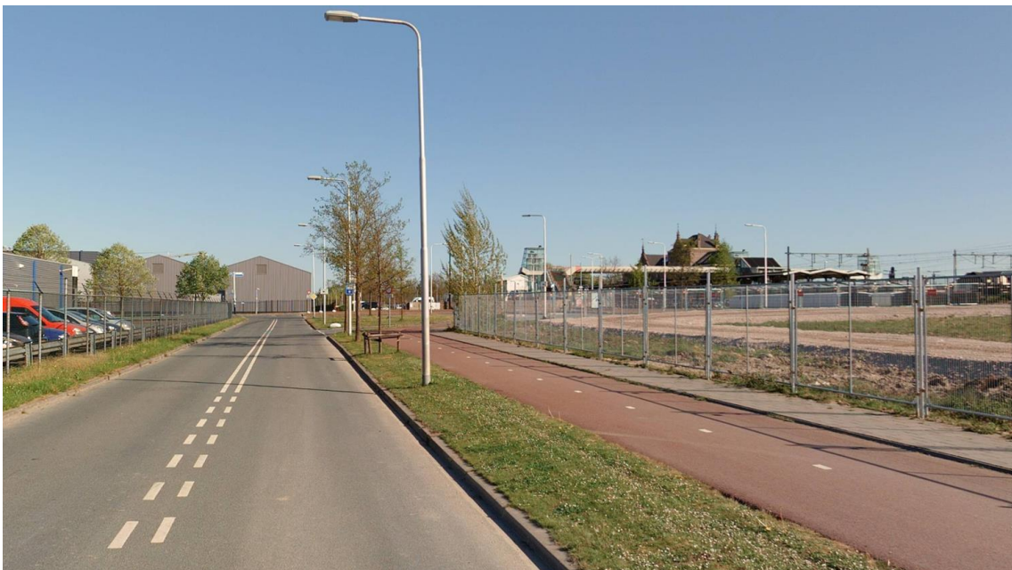
Spoorzone; zicht op hoek van bebouwing Fruitmasters
