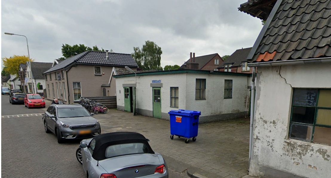
Fig. 2.4 Te slopen bedrijfsbebouwing (werkplaats)
