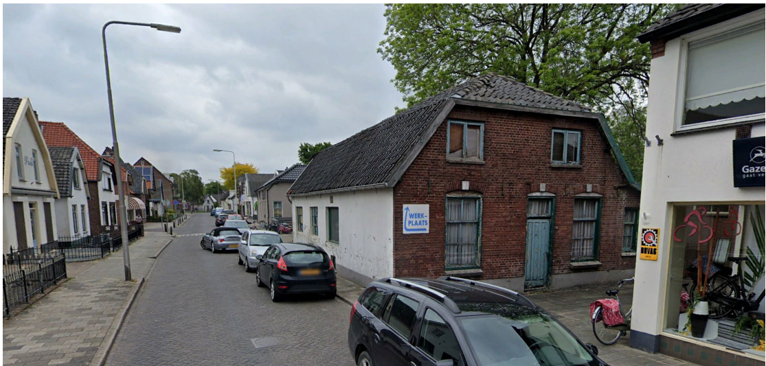
Fig. 2.3 Te slopen woonhuis (westzijde)
