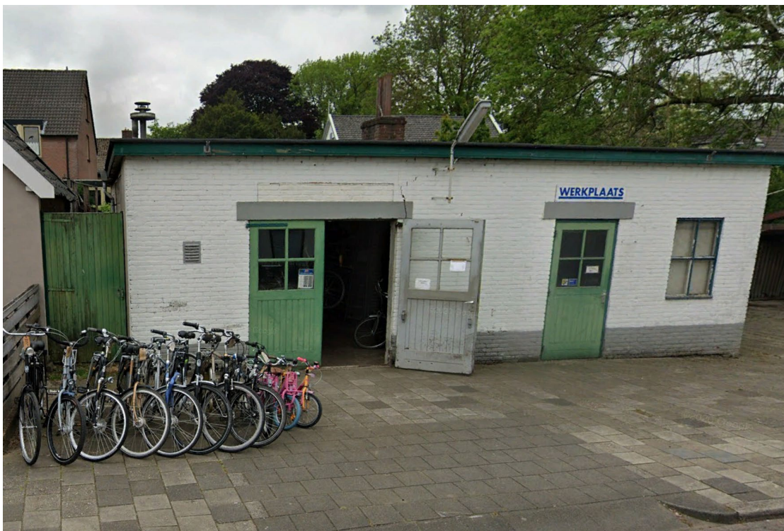
Fig. 2.5 Te slopen bedrijfsbebouwing (werkplaats)
