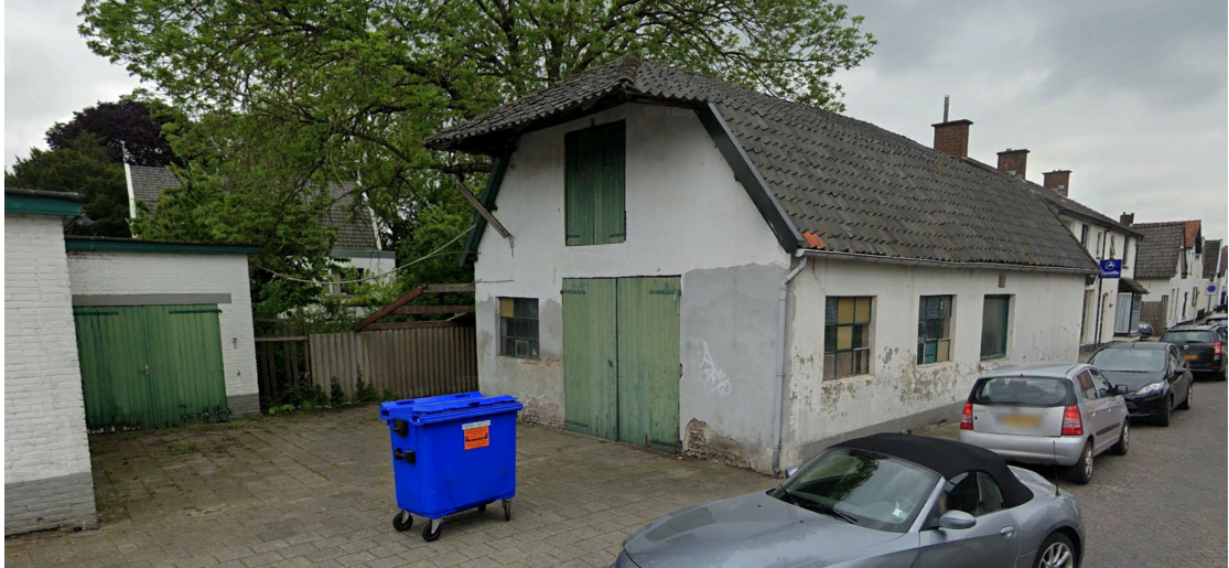
Fig. 2.2 Te slopen woonhuis (oostzijde)
