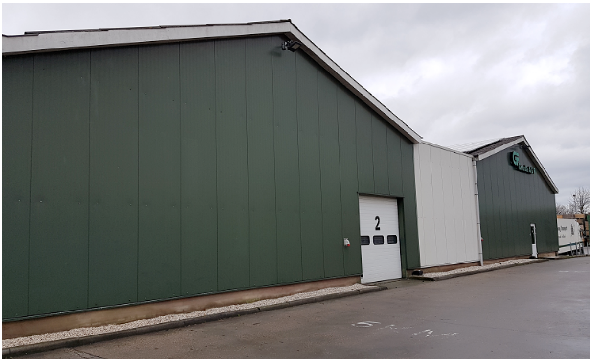
Gevel bedrijfsgebouw gericht op het zuidoosten
