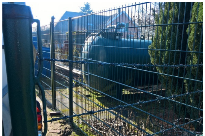
Foto 6: bovengrondse dieselolietank
