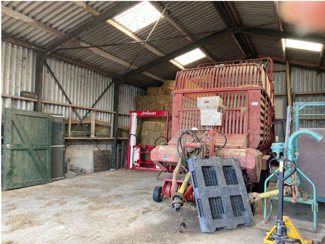
• Afbeelding 11: binnenzijde schuur (blijft behouden)
