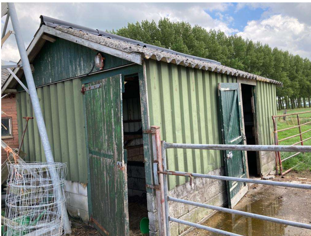
• Afbeelding 7: te slopen schuur
