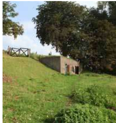
batterijen en betonwerken Meerdijk
