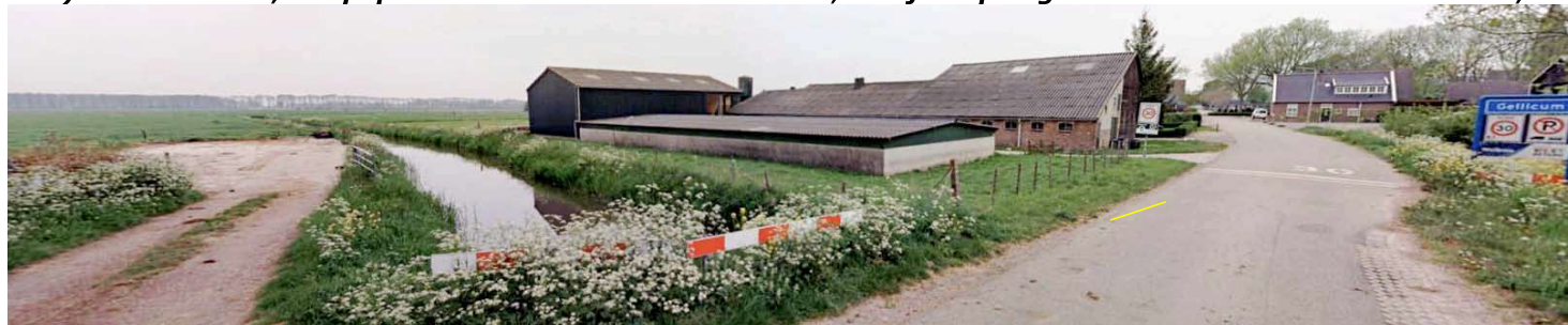
...ter hoogte van de Vliet worden de stallen beeldbepalend, tonen zich kaal aan de passant.
