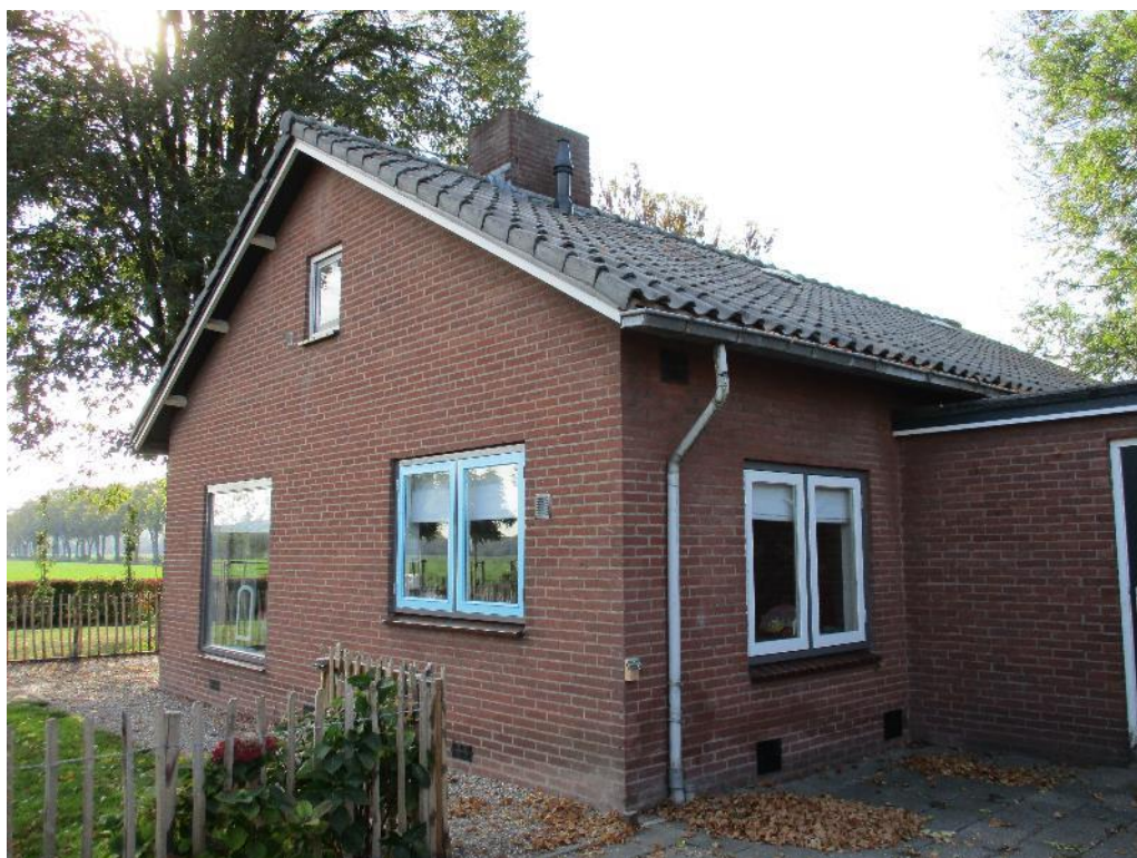
Figuur 1 De planlocatie is gelegen aan de Spijkse Kweldijk 66 te Spijk. Het perceel bestaat uit een bedrijfswoning met garage, voormalige veestal, loods en weide. De bedrijfswoning is opgetrokken uit gemetselde steense muren en een zadeldak met dakpannen.
