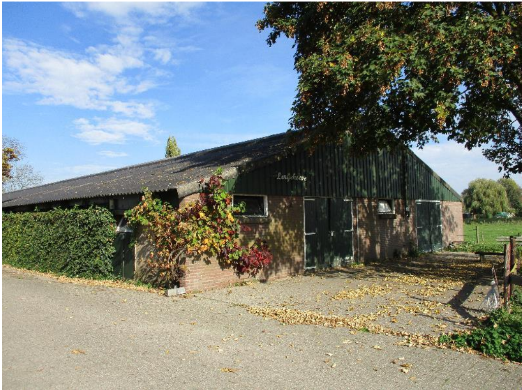
Figuur 3 De voormalige veestal is opgetrokken uit gemetselde steen muren, damwandplaten en een golfplaten dak.
