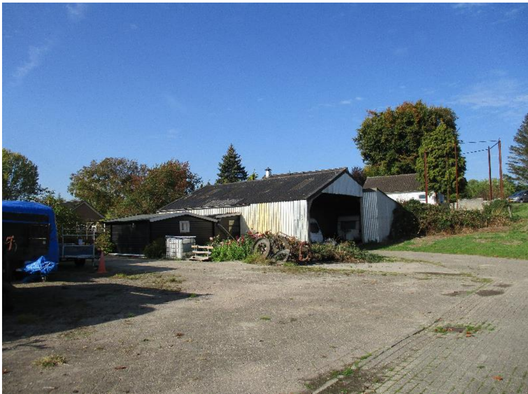
Figuur 4 De loods is opgetrokken uit witte damwandplaten en een golfplaten dak.
