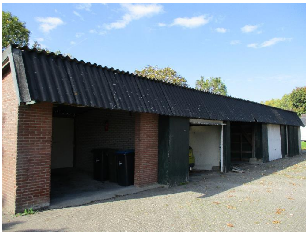
Figuur 2 De garage is opgetrokken uit één laag gemetselde steense muren en een golfplaten dak. Het merendeel van het perceel bestaat uit verharding.
