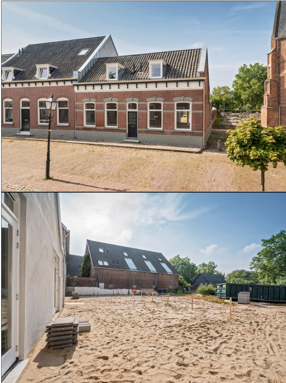
Afbeelding 2. Huidige situatie aan de Voorstraat 4-6 in Asperen (bron: Funda).
