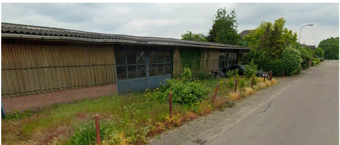
Fig. 2.4 Te slopen bedrijfsbebouwing
