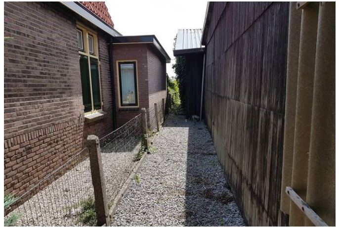
Foto 2: terreinstrook oostzijde voormalig bedrijfsgebouw (vanaf noordzijde)
