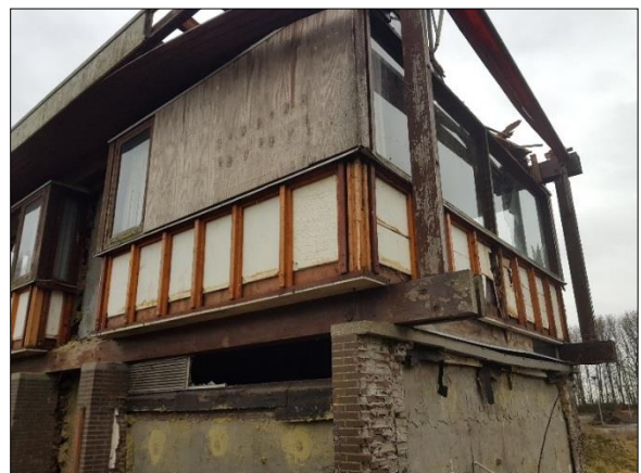
Figuur 9. Close-up half gesloopte voormalige verkeerstoren
