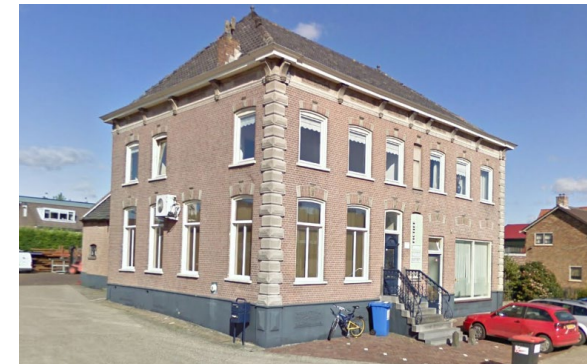
Karakteristieke T-huis aan de Achterstraat, daarachter staan de schuren.
