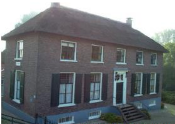
Referentie gevel hoofdgebouw
