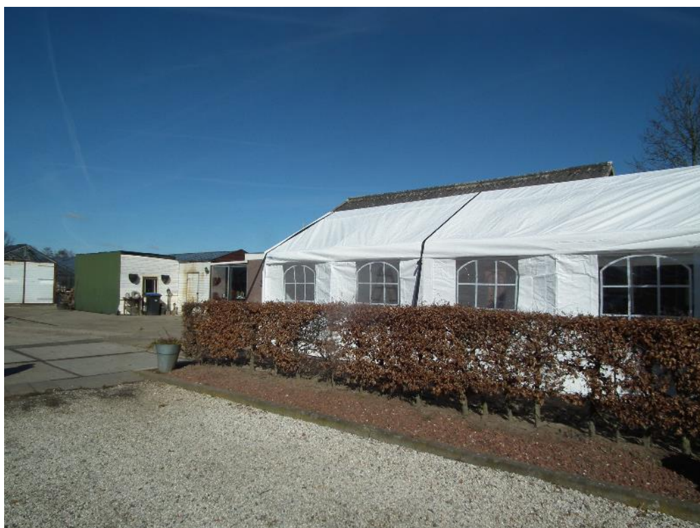
Figuur 2 De woning is opgetrokken uit gemetselde muren en een zadeldak met dakpannen. De aanbouw is opgetrokken uit twee glazen schuifdeuren en een bitumen dak. De oprit, gelegen tussen de woning en de paardenbak, bestaat uit kiezelstenen.
