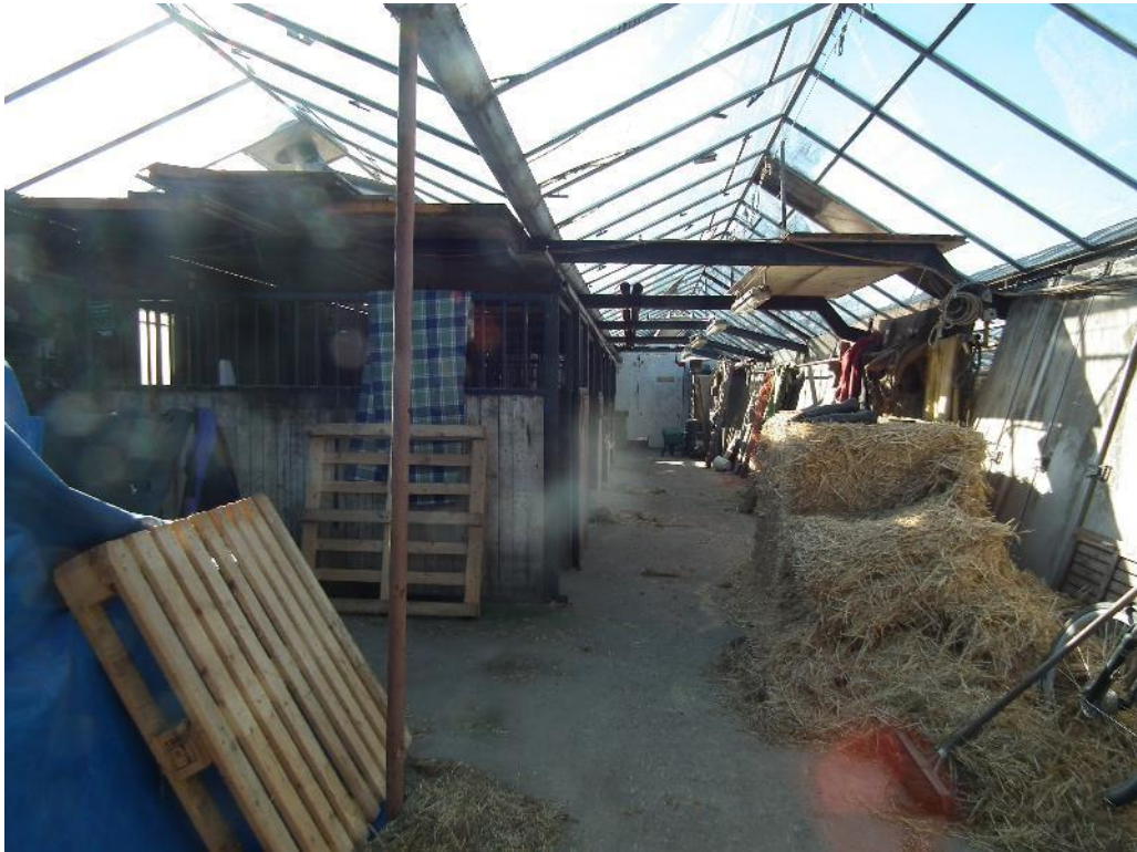
Figuur 3 Naast de aanbouw is glastuin bebouwing aanwezig, welke is opgetrokken uit een kunststof gevelafwerking en glazen dak.
