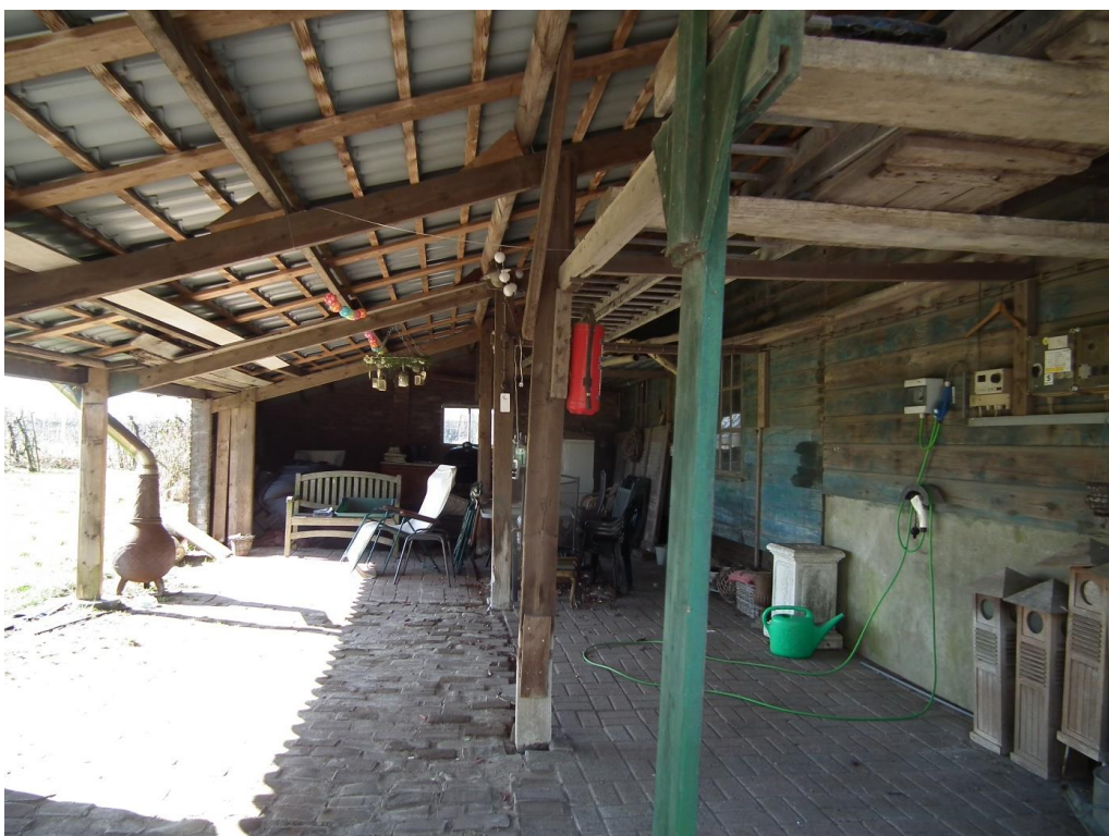
Figuur 2 De schuren worden met name gebruikt als opslaglocatie van materialen. Tevens is een overkapping met terras tegen een van de schuren aanwezig.
