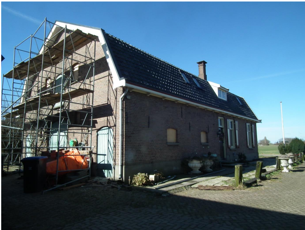
Figuur 1 Het plangebied is gesitueerd aan de Gerestraat 3 te Heesselt. Op de locatie zijn een woning en 2 schuren aanwezig.
