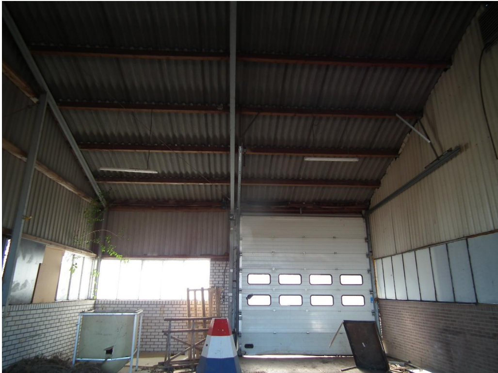
Figuur 3 De binnenzijde van de loods bestaat uit een zeer open structuur en is recentelijk niet in gebruik genomen.
