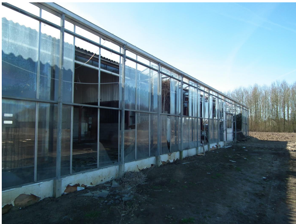
Figuur 1 De te saneren opslagloods bestaat voor de helft uit kas, de andere helft is opgetrokken uit metselstenen en damwandplaten. Het dak betreft golfplaten.
