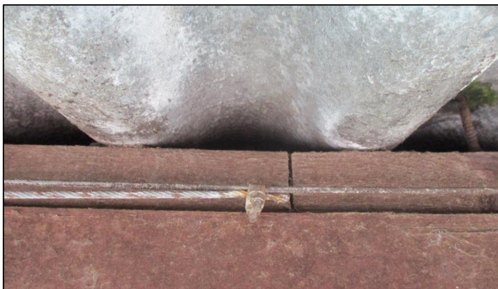
Figuur 5 De ruimte tussen het dak en dakbeschoot in stal 1 is voor de huismus bereikbaar via de dakranden.
