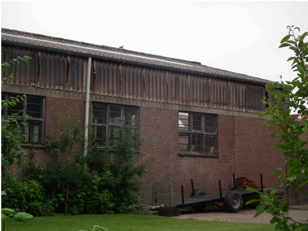
Figuur 1 De planlocatie is gelegen tussen de Achterstraat en de Huis te Beestlaan te Beesd en bestaat uit een vervalLEN bedrijfshal met gemetselde niet geïsoleerde muren en een zadeldak met uit golfplaten zonder dakbeschot.
