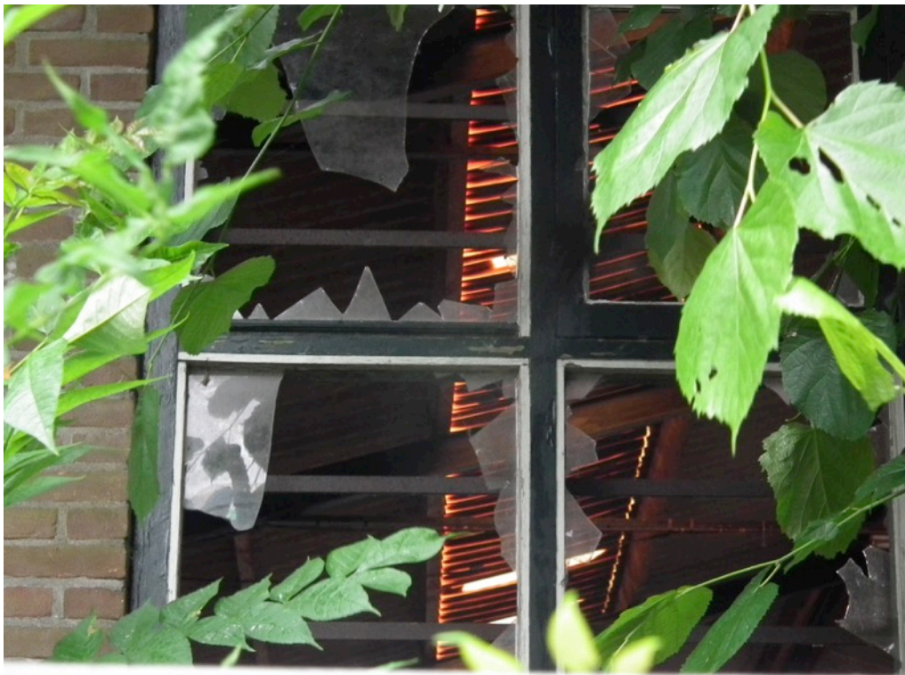
Figuur 4 Onder de golfplaten is geen dakbeschot aanwezig, waardoor het voorkomen van nestlocaties van huismussen en gierzwaluwen binnen het plangebied uitgesloten kunnen worden.
