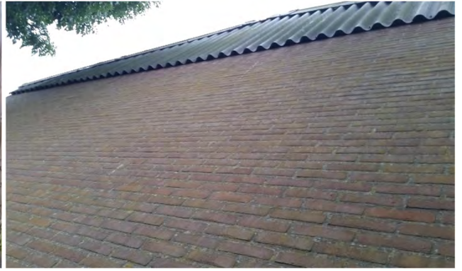
achterzijde loods, asbest-schot
