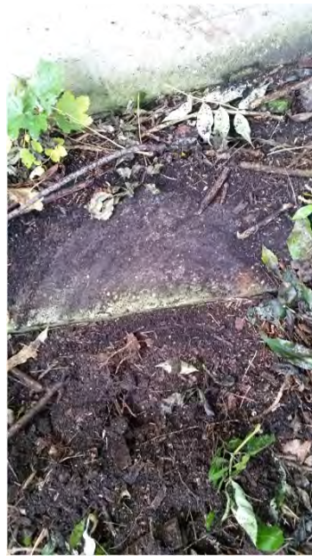
de onverharde bodem achter de loods
