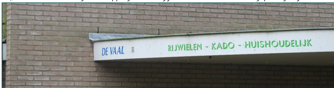
Figuur 3.1 Open stootvoegen in de muur van Voorstraat 51 kunnen geschikte invliegopeningen worden als de overkapping wordt gesloopt. Hier mag dan geen verstoring van vleermuizen plaatsvinden.
