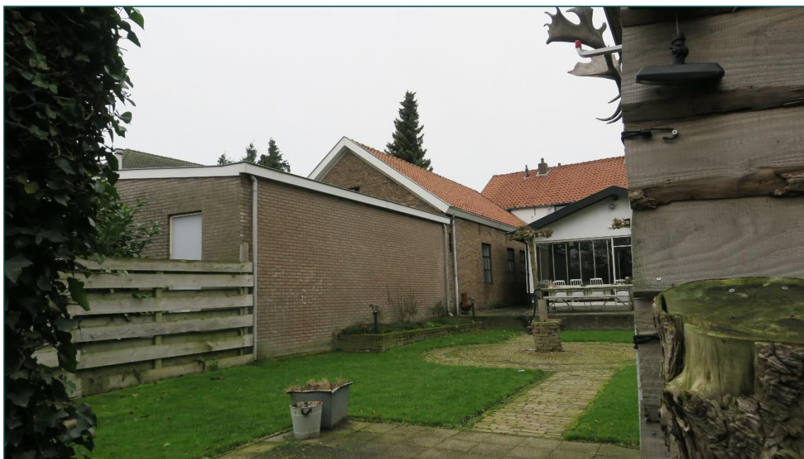
Figuur 1 De planlocatie betreft een bedrijfsruimte bestaande uit een bakstenen gebouw met dakpannen zadeldak en een uitbouw met plat bitumen dak.
