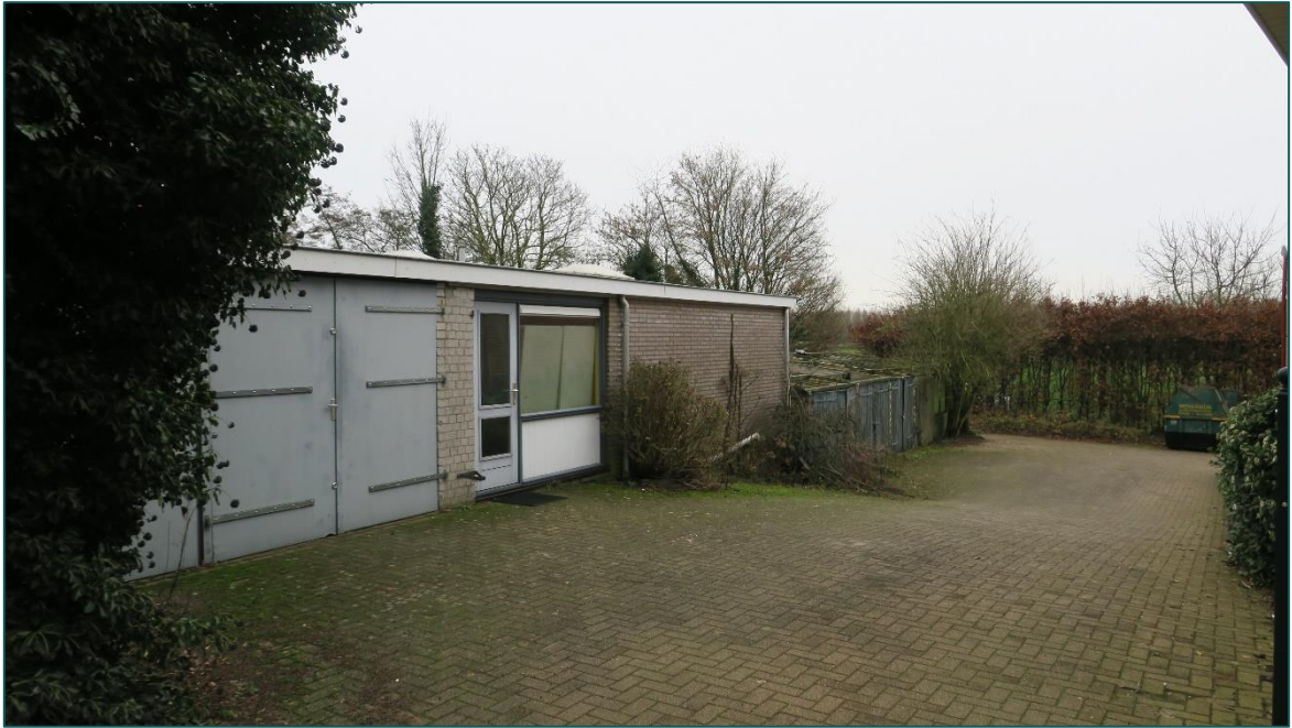
Figuur 1.4 Het te slopen pand heeft een uitbouw met plat dak (foto) en ook het verwaarloosde bijgebouw wat daarachter te zien is zal worden gesloopt.
