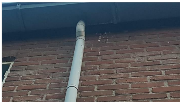
Afbeelding 2.3 | Open stootvoeg achterzijde B. J.W. Hondelinkstraat 30 met gierzwaluwnestplaats
