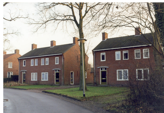
Geveluitkraging in het metselwerk, tuitgevels en raam- en deuromlijsting
