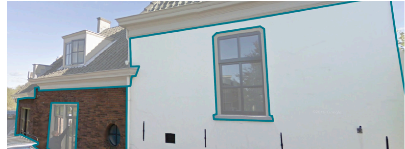
Roodbruin metselwerk afgewisseld met wit gepleisterde gevels
