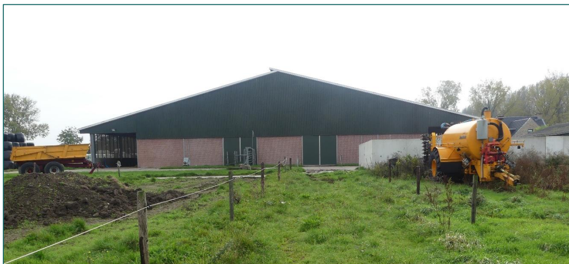
Figuur 1.3 Op de planlocatie is men onder andere voornemens om ligboxenstal uit te breiden.
