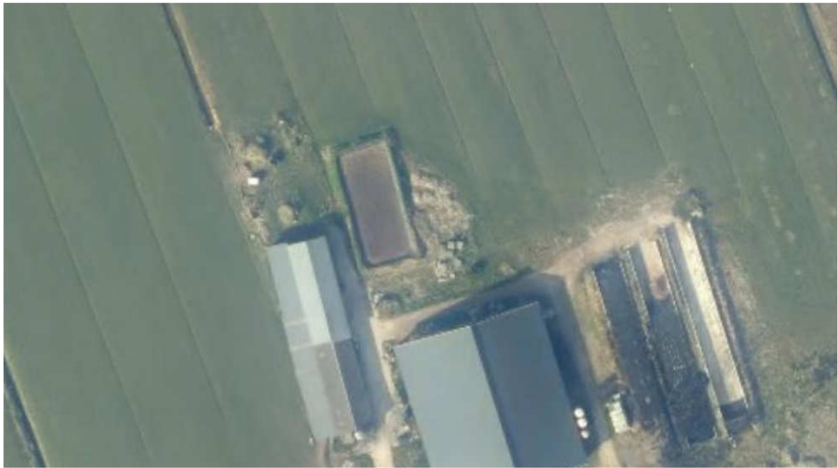
2013 luchtfoto met mestbassin en opslag materialen
