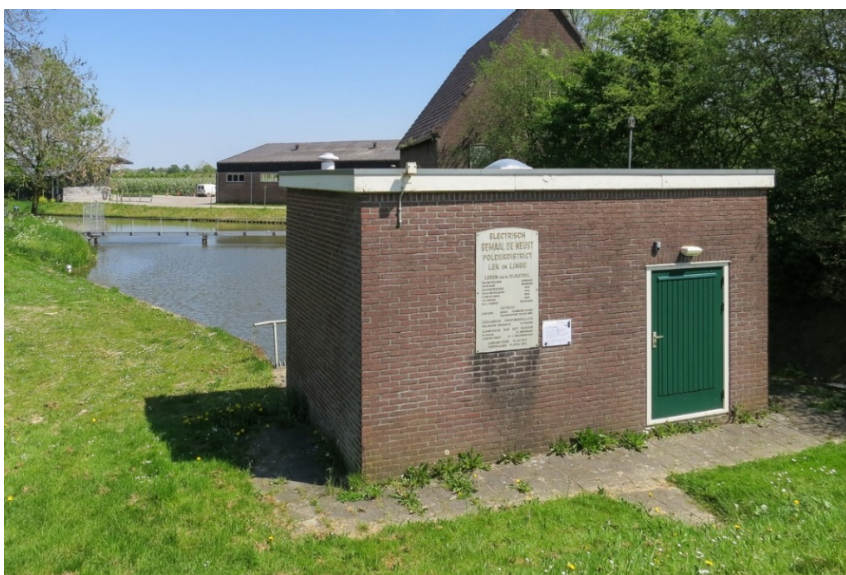
Figuur 2.10 Gemaal a (gebouwd jaren '50)
