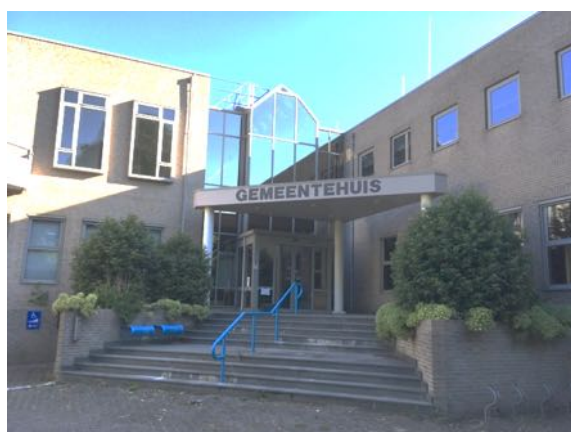
Figuur 5. Entree van het gemeentehuis aan in de zuidgevel.
