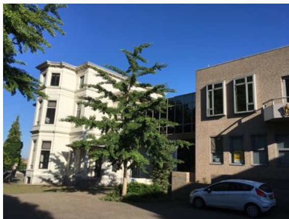
Figuur 4. Zuidgevel complex met links het oude raadhuis en rechts het gemeentehuis.
