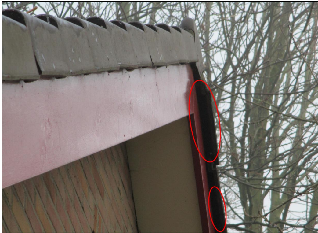
Figuur 1.3 Kierende kantpannen waardoor vleermuizen de ruimte onder de dakpannen kunnen betreden.
