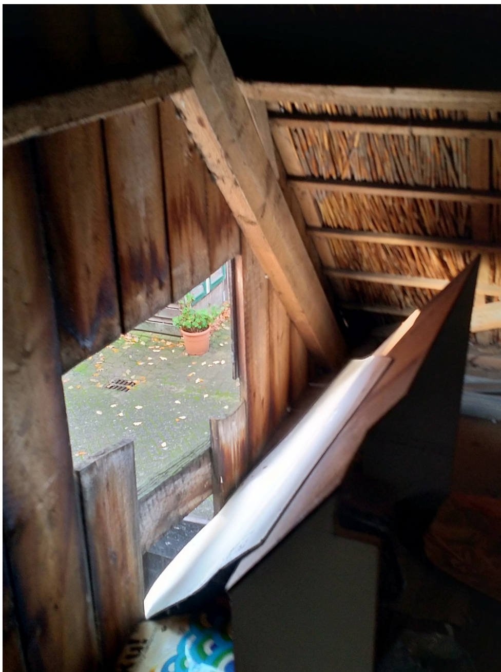
Eén van de gaten van de noordelijke schuur welke toegang biedt tot de zolder. Foto: M.S. de Haan Ecoresult B.V.
