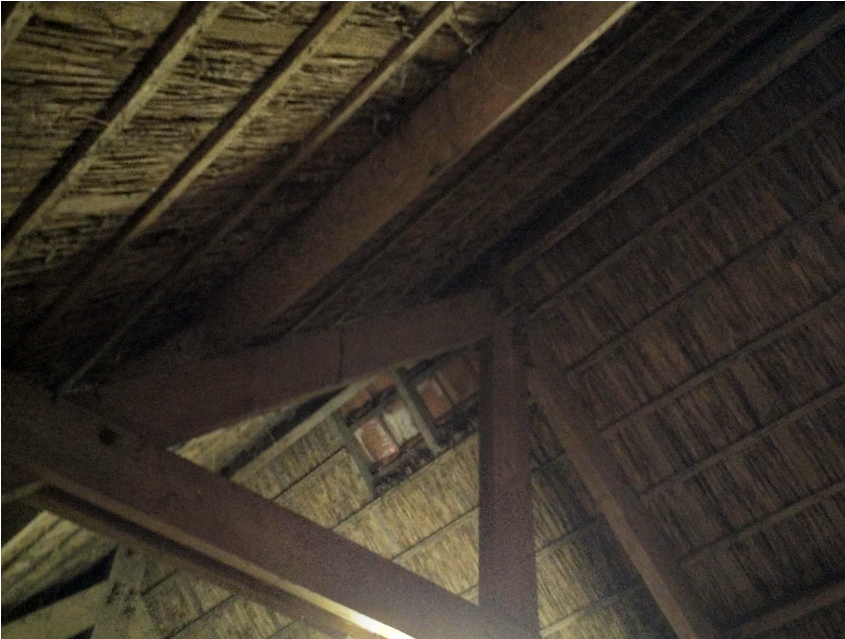
Afbeelding 7: Houten balken in de noordelijke schuur welke geschikt zijn voor vleermuizen. Deze balken zijn ook in de zuidelijke schuur aanwezig. Foto: M.S. de Haan | Ecoresult B.V.
