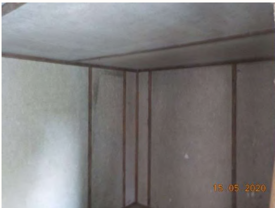
Foto 5: Bron B01, asbestcement koelcel inclusief deur
