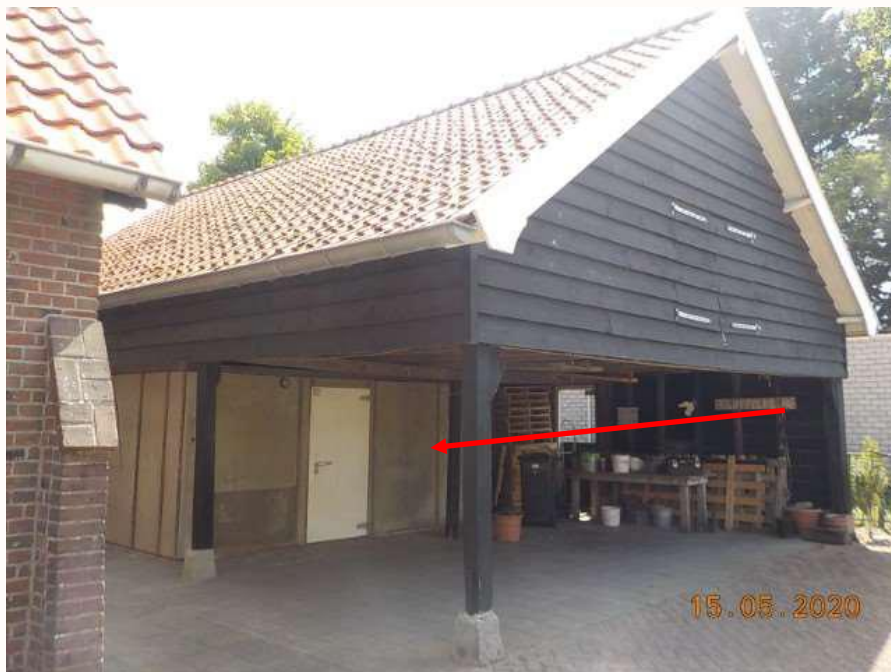
Foto 1: Bron B01, asbestcement koelcel inclusief deur
