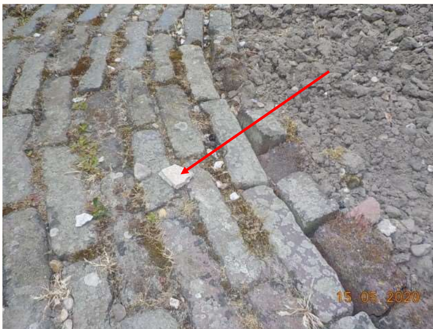
Foto 16: Reeds verwijderde restanten asbestcement in voortuin
