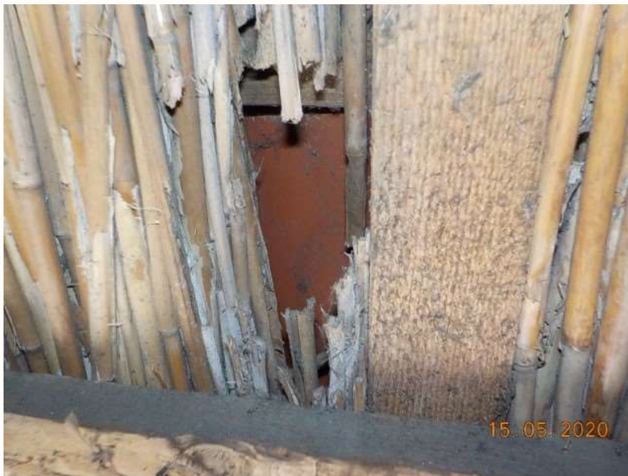
Foto 15: voormalige stal, rieten dak met dakpannen
