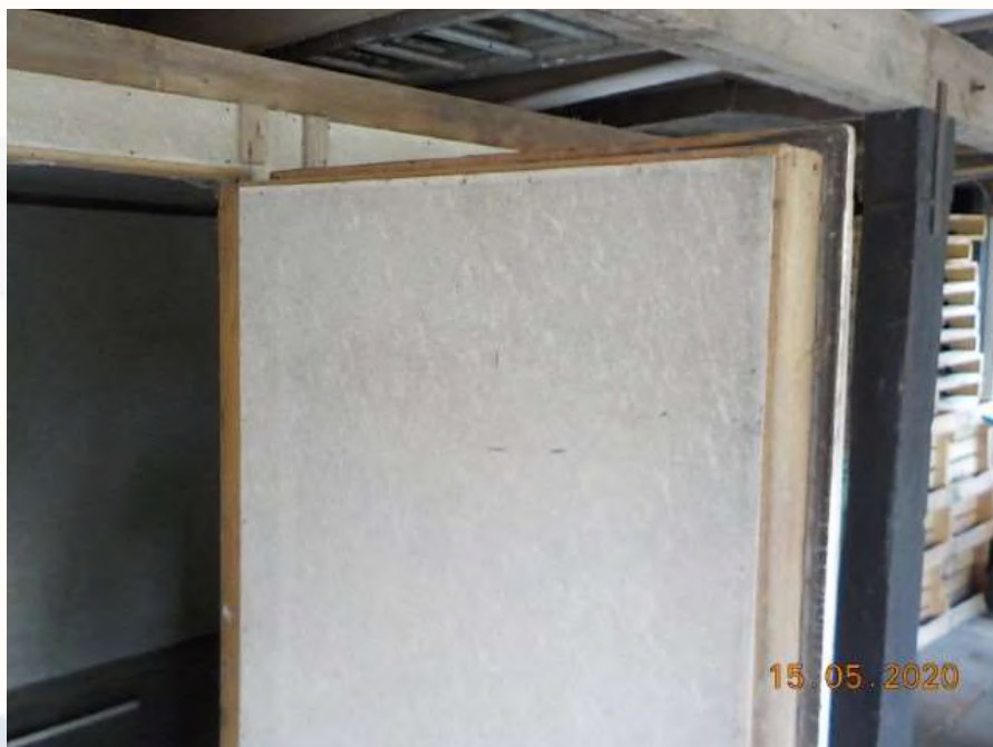
Foto 2: Bron B01, asbestcement koelcel inclusief deur
