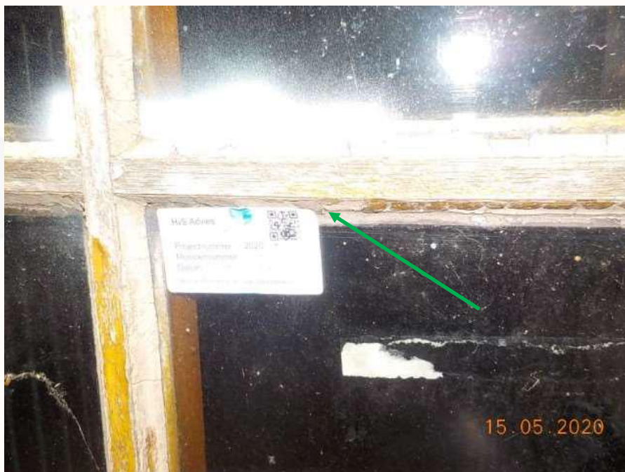
Foto 12: Bron B04, asbestvrije beglazingskit
