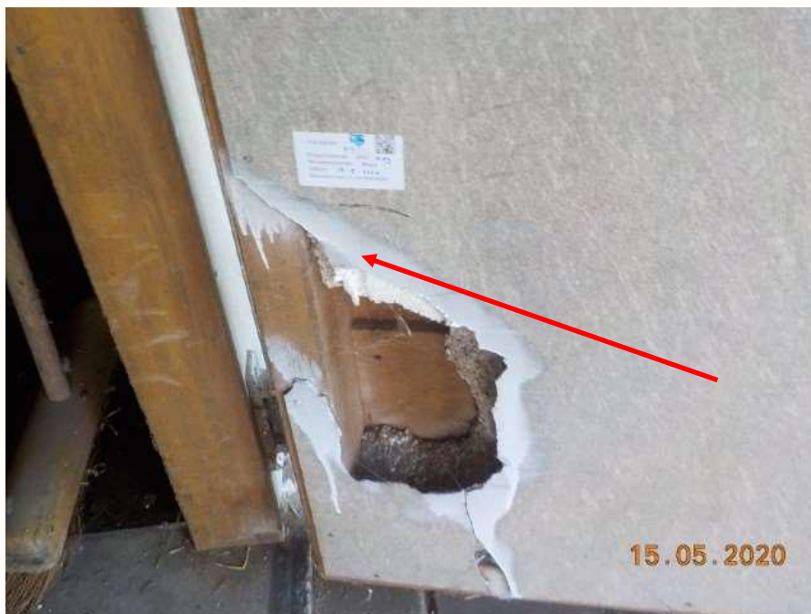
Foto 3: Bron B01, asbestcement koelcel inclusief deur
