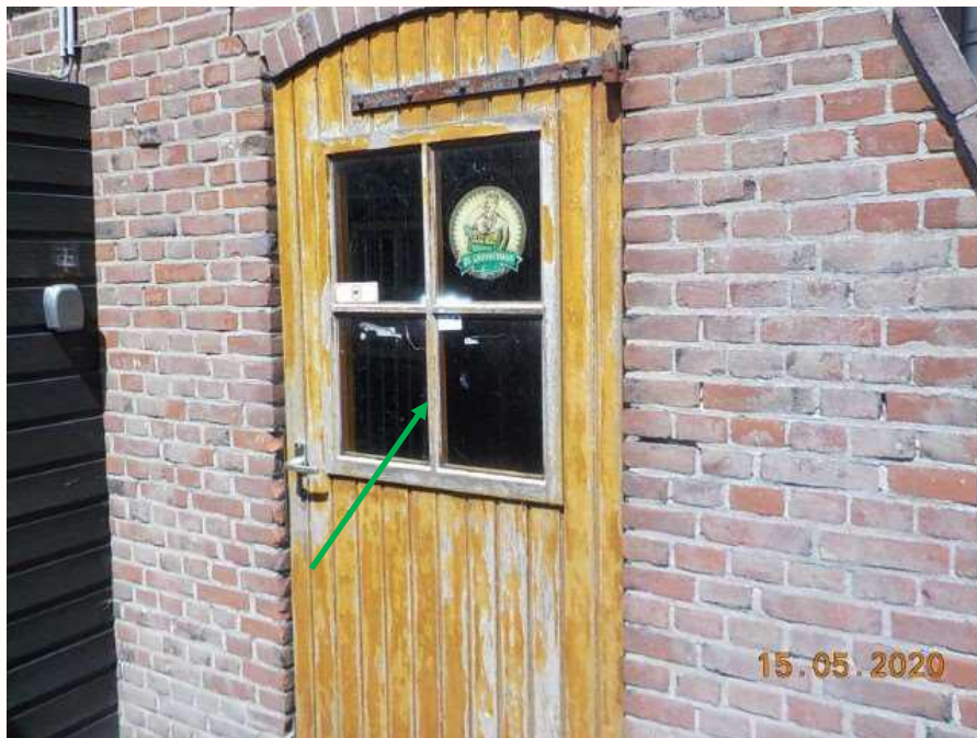
Foto 11: Bron B04, asbestvrije beglazingskit
